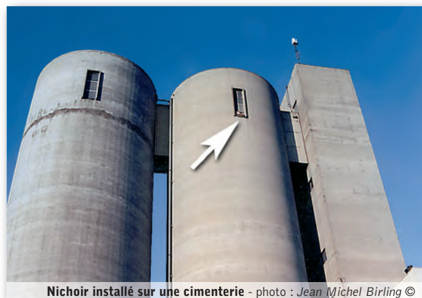
Nichoir installé sur une cimenterie - photo : Jean Michel Birling ©
