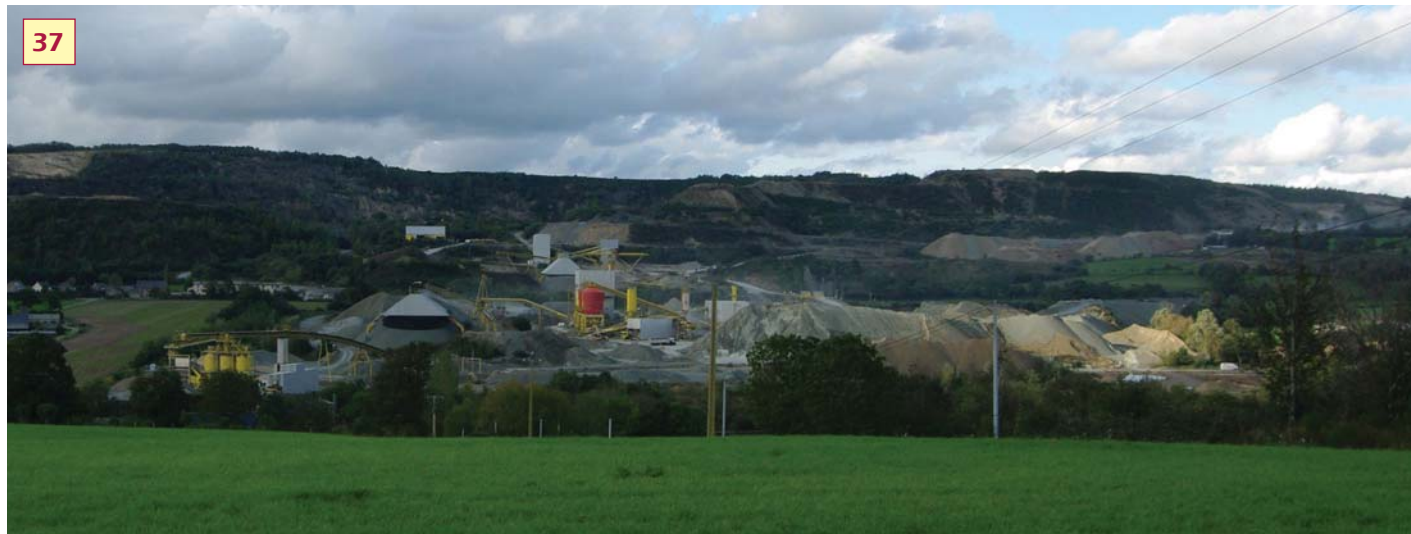
37 Répartition des différents bâtiments le long de la pente, du nord au sud.
