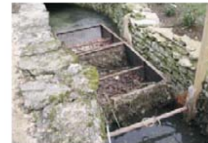
Filtre mobile installé sur un cours d'eau
