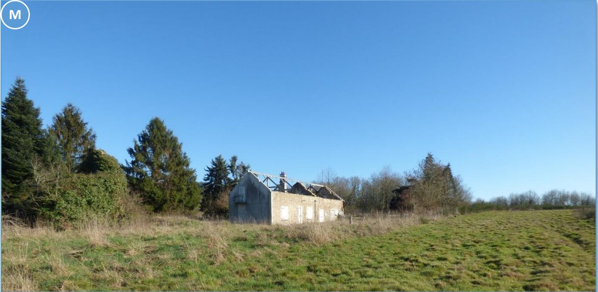
Fig. 30 : Vue sur la partie sollicitée en intégration au périmètre (ancienne habitation des Manettes)
