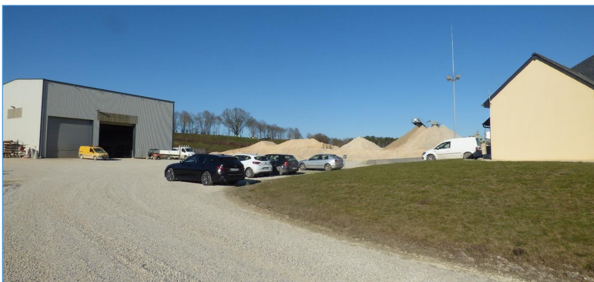
Fig. 23 : Vue sur les bureaux et la plateforme de stockage / des installations
