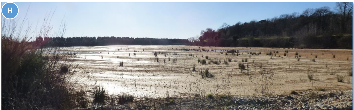
Fig. 25 : Vue sur un des anciens bassins de décantation en cours de séchage
