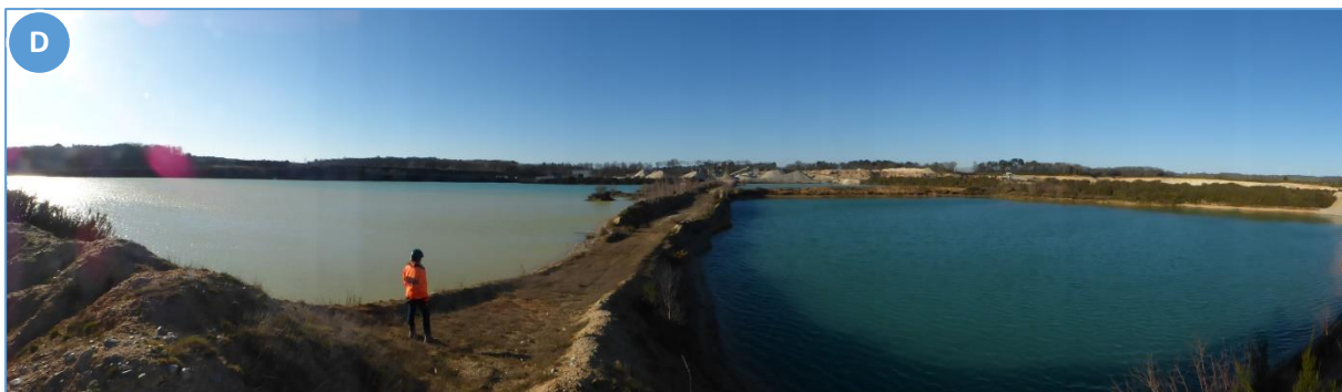
Fig. 22 : Vue sur l'un des bassins de décantation (à gauche) et sur des bassins d'eau claire (à droite)
