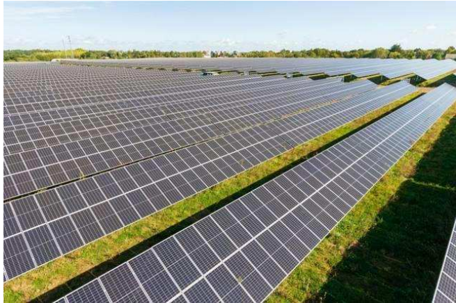
Figure 32 : Illustration de l'espacement entre les rangées de panneaux photovoltaïques (FS Marc Energies, une réalisation IEL)
