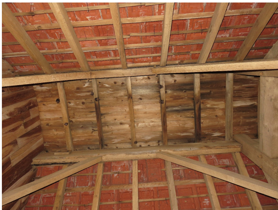
Figure 9: Petits rhinolophes sur la charpente de la chapelle Saint-Yves
