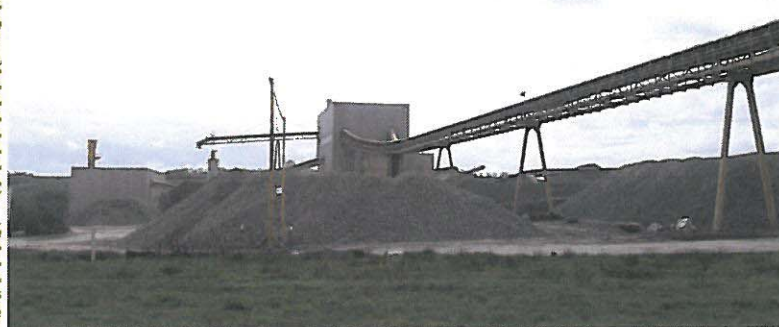
1 - Convoyeurs et silos de stockage
