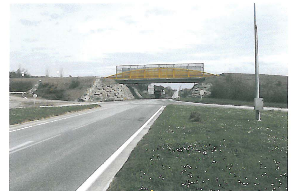
Pont traversant la RD 32
