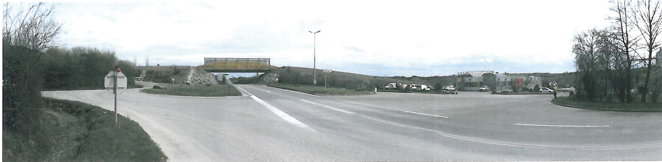
Accès au site
