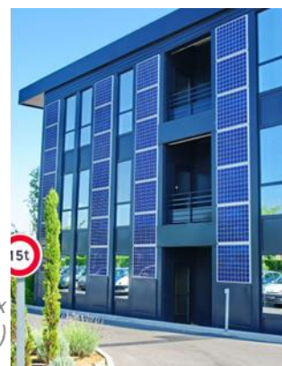
Façade d'entreprise avec panneaux photovoltaïques (batirama)
