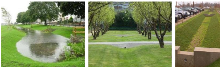
Bassin tampon paysager - Boulevard C.Cros – Ifs (14)
