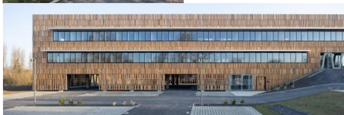
Illustration : bâtiment de l'ANSES – Javené 35 – construction utilisant la topographie du terrain pour l'intégration des aires de stationnement sous les bureaux.
