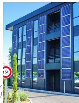
Façade d'entreprise avec panneaux photovoltaïques (batirama)
