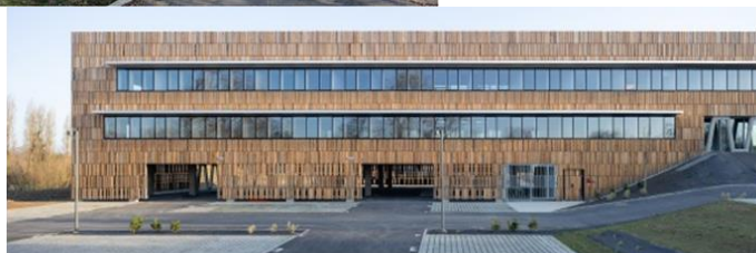
Illustration : bâtiment de l'ANSES – Javené 35 – construction utilisant la topographie du terrain pour l'intégration des aires de stationnement sous les bureaux.
