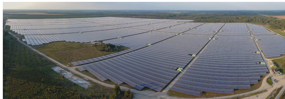
Parc photovoltaïque de Cestas (sept. 2015)
