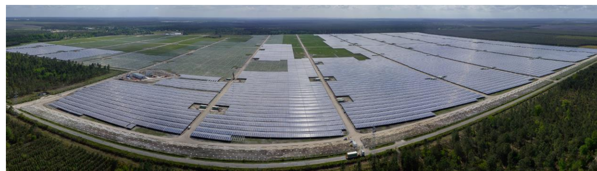
Parc photovoltaïque de Cestas en construction - Mai 2015
