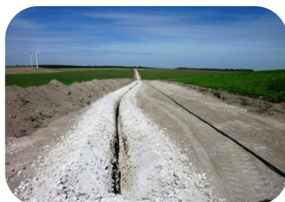
Réalisation des pistes et du câblage
