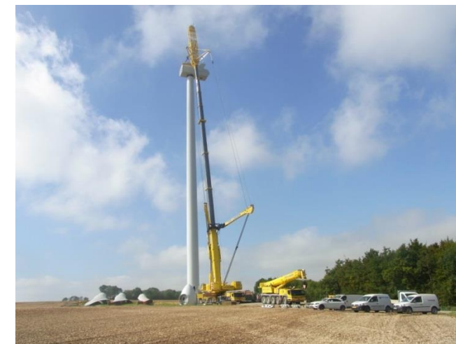
Installation de la nacelle sur l'éolienne n°6
