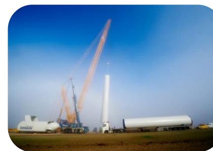
Livraison et Montage des tronçons de mâts
