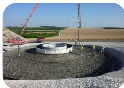
Coulage de la fondation
