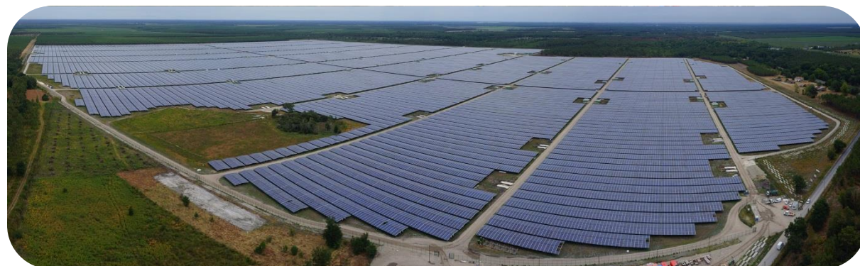
Figure 4 : Chantier de la centrale photovoltaïque de Cestas (300 MW)
