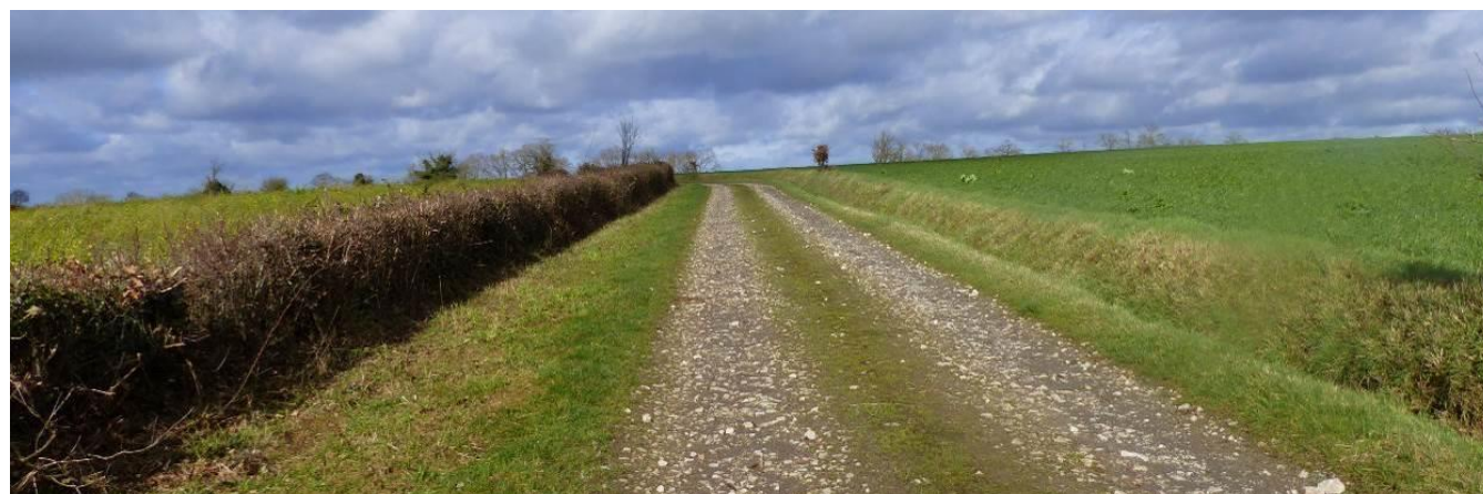
L'accès principal s'appuie sur un accès existant bordé de fossés et d'une haie arbustive
