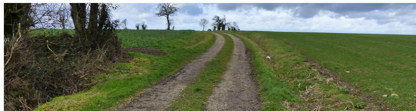
Le chemin d'accès existant présente un aspect rural, avec ses bandes de roulement espacées d'une bande enherbée
