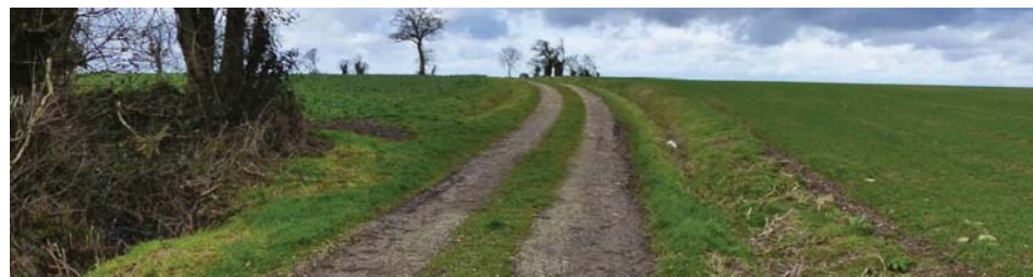
Le chemin d'accès existant présente lui aussi un aspect rural, avec ses bandes de roulement espacées d'une bande enherbée
