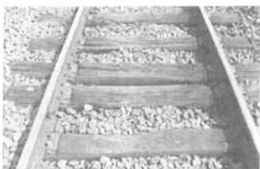
Rails courts sur traverses bois
