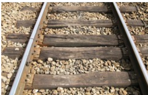
Rails courts sur traverses bois
