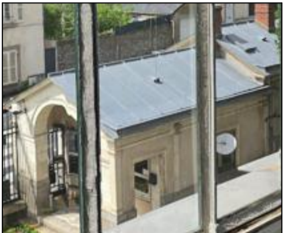
Annexe Sud - Toitures Zinc
