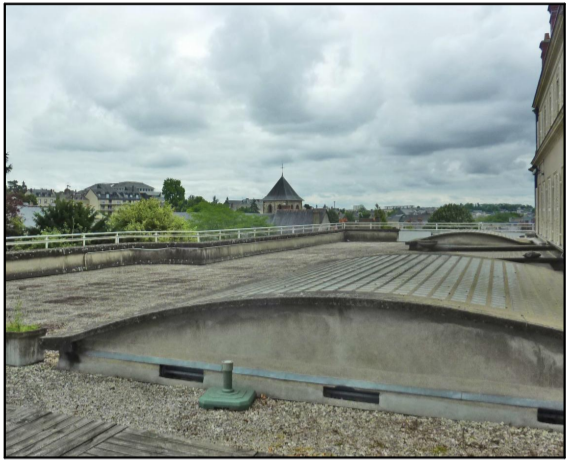
Bât. principal - R+1 - Puits de lumière déposé
