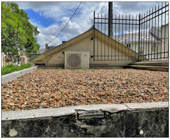
Annexe Sud - Toiture-terrasse
