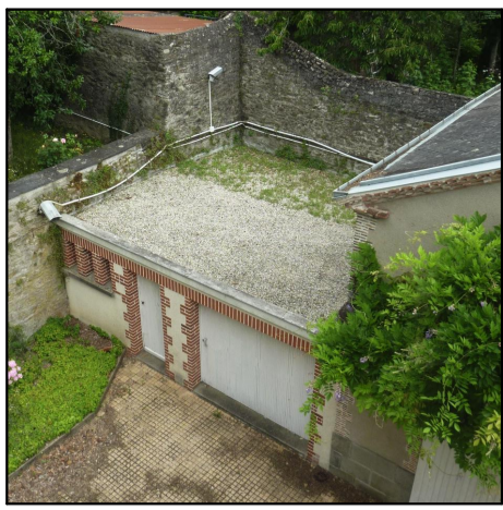
Annexe Nord - Toiture-terrasse
