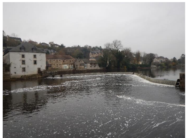
Barrage de Bootz
