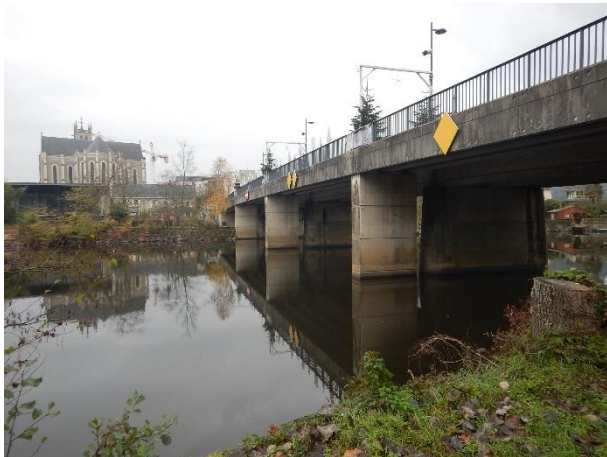
Pont de Changé-Lès-Laval
