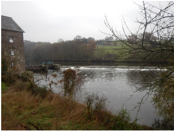
Barrage de Belle Poule
