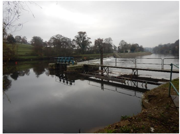
Vannage et microcentrale du barrage de Belle Poule
