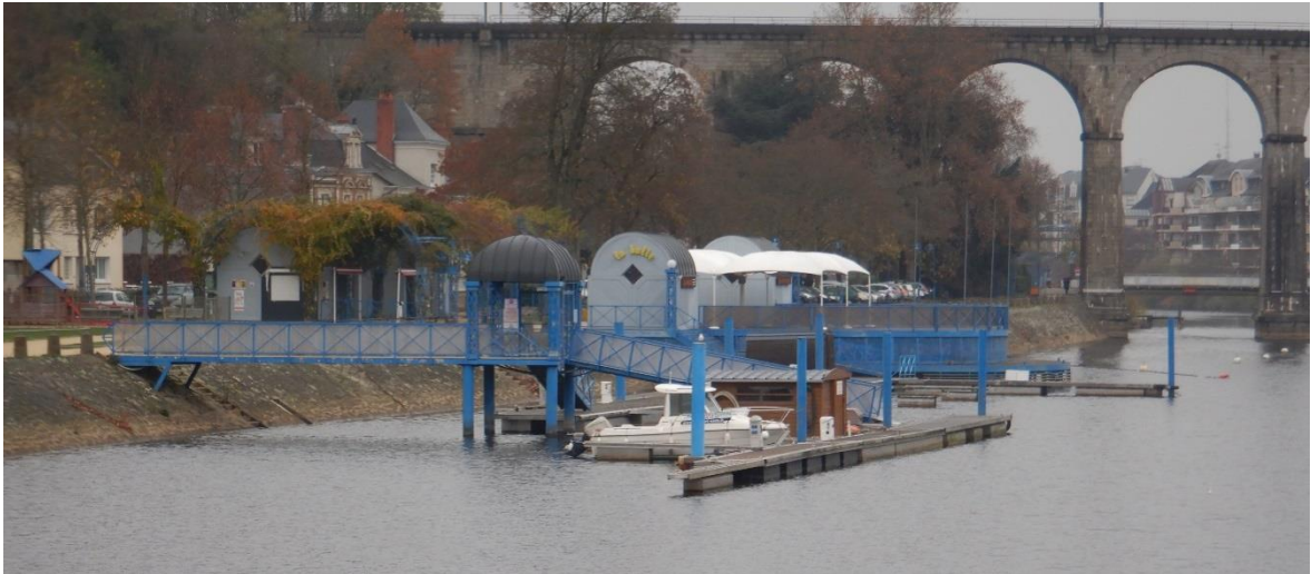
Fig. 15. Halte nautique de Laval en novembre 2018 (ARTELIA)
