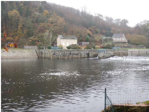
Ecluse du barrage de Bonne
